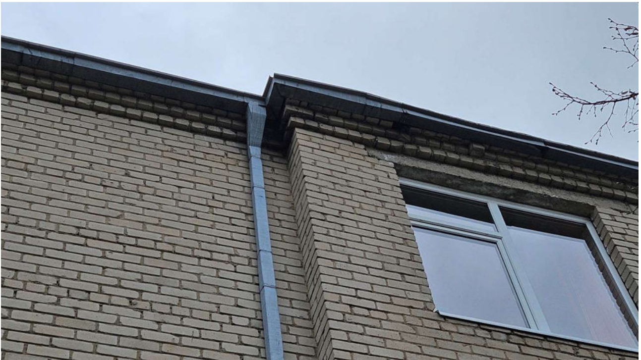
5.12 pav. Tipinės mūrinių karnizų pažeidos
