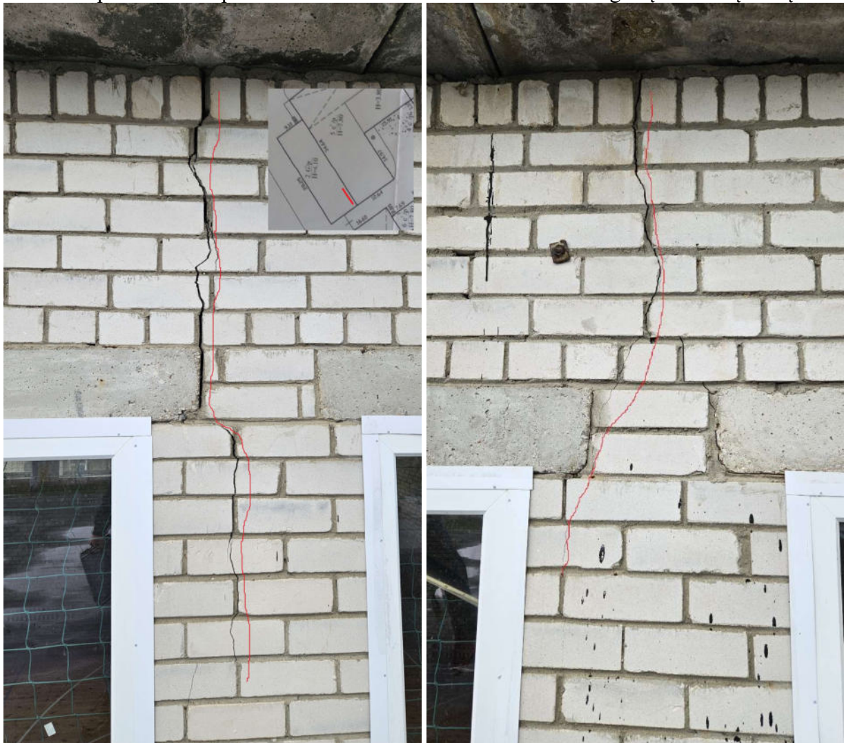
5.20 pav. Supleišėję salės tarpulaniai (avarinės būklės požymiai)
