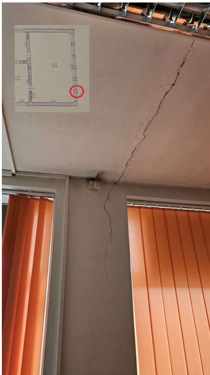
5.21 pav. Dėl temperatūrinių deformacijų supleišėjęs 3 aukšto tarpulangis,
