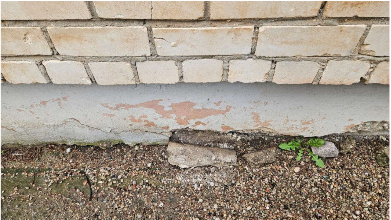
5.6 pav. Cokolis pažeistas drėgmės poveikio
