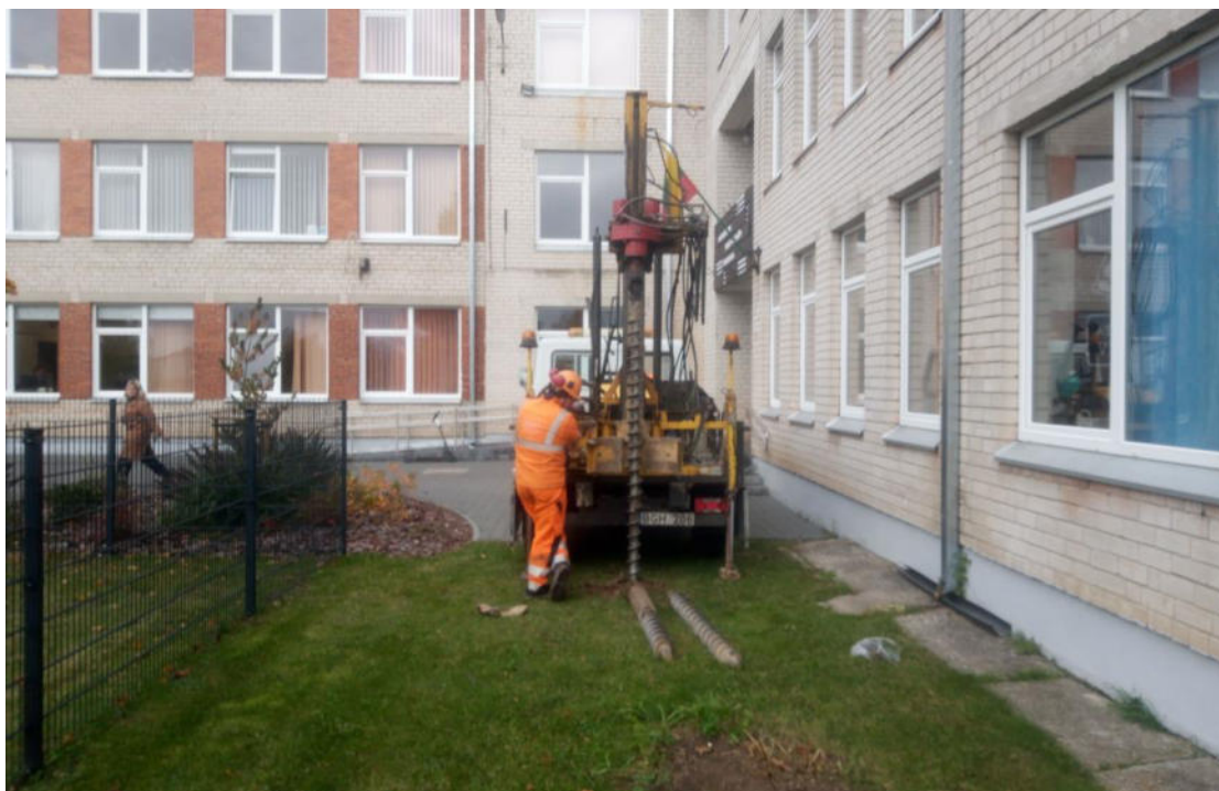
1 pav. Lauko darbai
