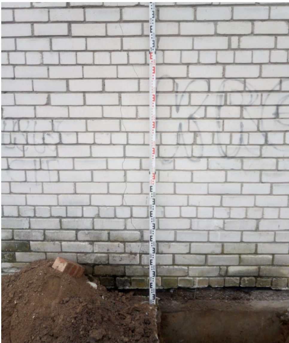
3 pav. Pastato būklė ties kasiniu K-1
