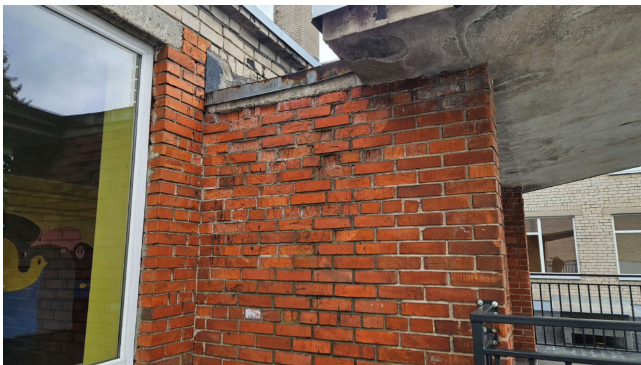
5.15 pav. Antrojo korpuso mūro erozija dėl netinkamo atmosferinių kritulių nuvedimo nuo stogo
