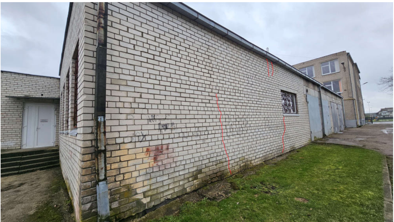
5.5 Plyšiai garažo sienose dėl pamatų nuosėdžių. Cokolis pažeistas drėgmės poveikio
