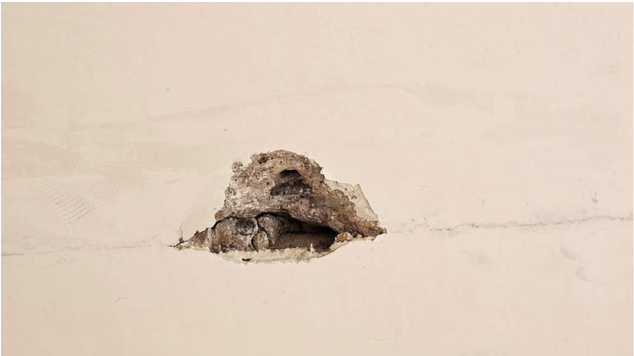
3.1 pav. Surenkamos gelžbetoninės tuštumėtos plokštės armatūros atodanga
