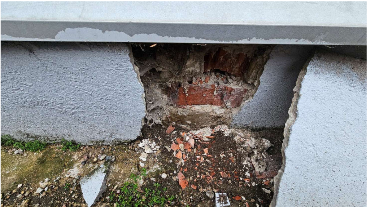
5.7 pav. Cokolis pažeistas drėgmės poveikio
