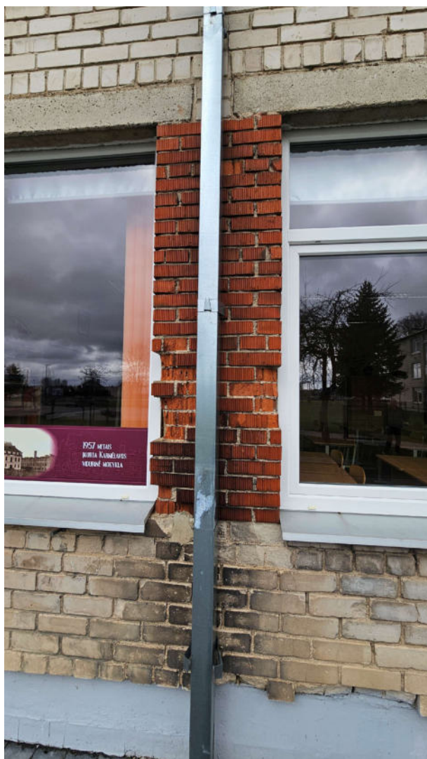
5.16 pav. Antrojo korpuso mūro erozija dėl buvusio netvarkingo lietvamzdžio
