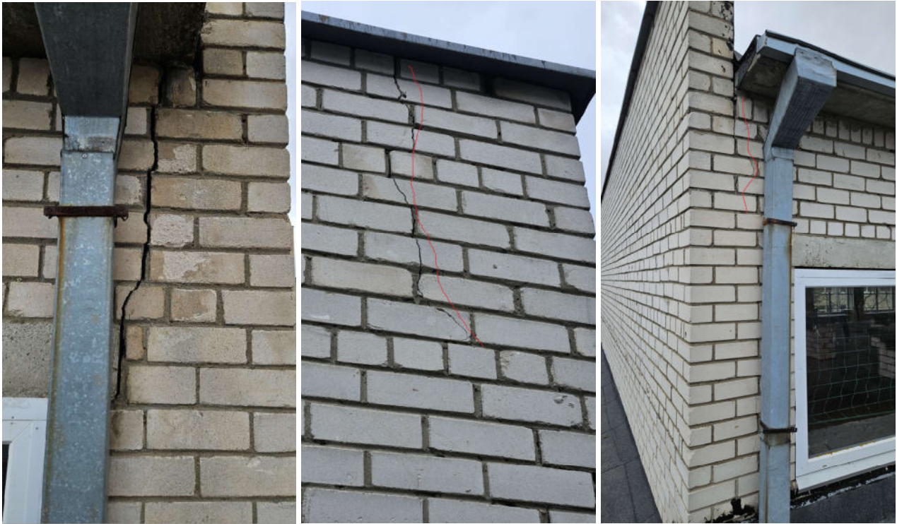
5.19 pav. Galinės sporto salės mūro sienos atitrūkusios nuo išilginių laikančių sienų
